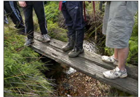
Canowie Brook Bridge
